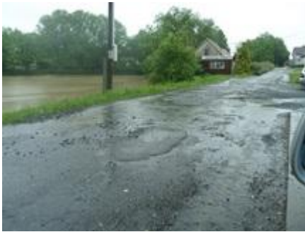
NEOPRAVENÁ ČÁST KOMUNIKACE
