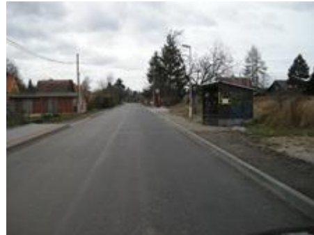
OPRAVENÁ ČÁST KOMUNIKACE
