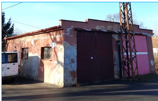
Obrázek 6 Hasičská zbrojnice – exteriér a střešní plocha
