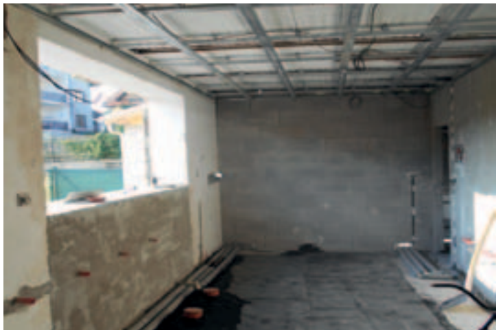
Tak se proměnila na koupelnu místnost, která dříve částečně sloužila jako sklad.
