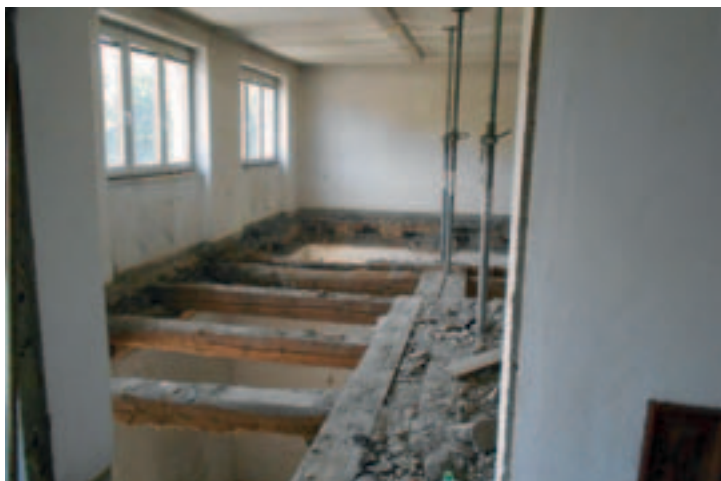
Původní zasedačka v době rekonstrukce nijak nenaznačovala, jak by měla nakonec vypadat třída.
