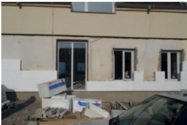
Proměnil se také vzhled budovy. Nejde jen o novou fasádu, budova je rovněž zateplená.
