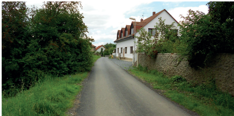
Na snímku je nová silnice U rybníků I. Rekonstrukce U Rybníků I a U Rybníků II stála dohromady 2 336 758,50 korun.
